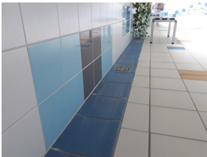
foto /52/ Detail napojení dlažby na obklad
