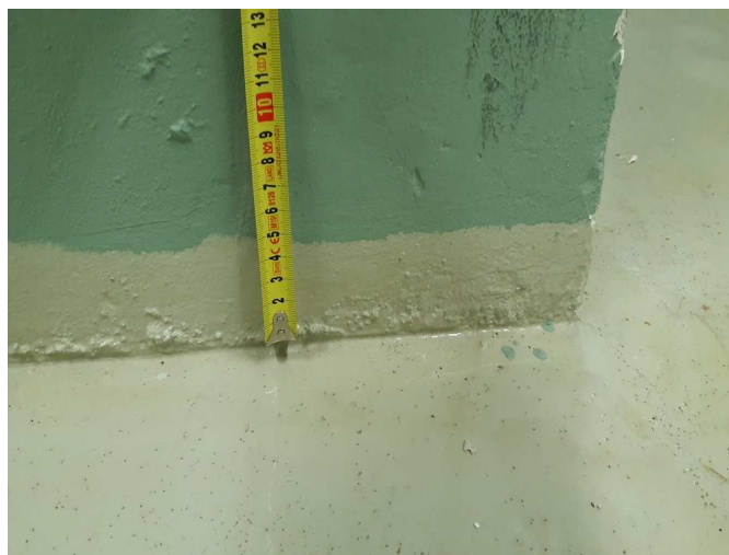
foto /4/ Ukončení nátěru na obvodové konstrukci
