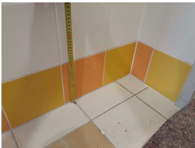
foto /20/ Detail napojení dlažby na obklad
