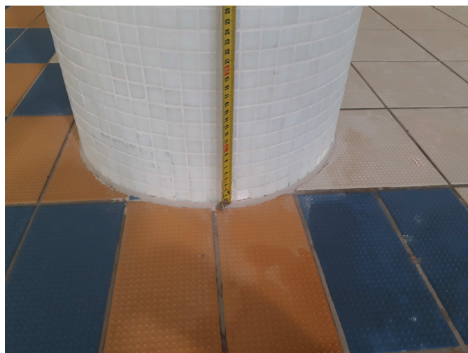
foto /38/ Napojení dlažby na mozaiku na nosných sloupech
