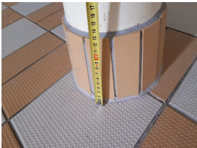
foto /32/ Ukončení dlažby na nosné sloupu
