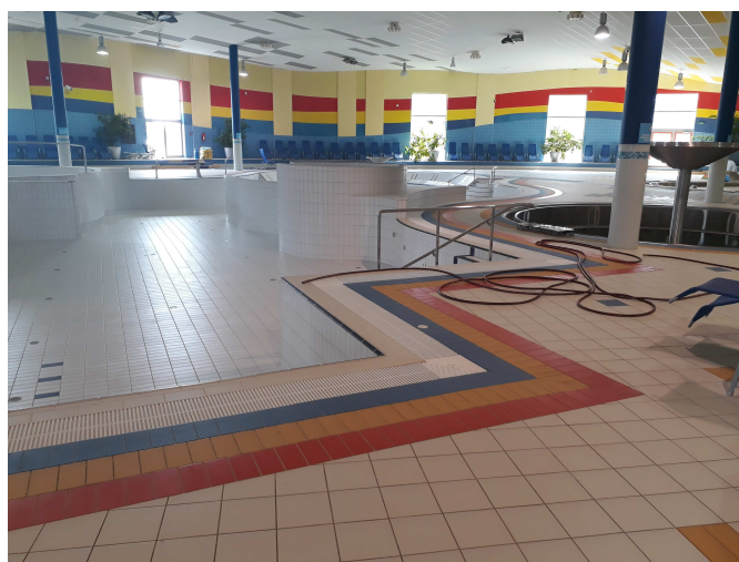
foto /36/ Ukončení dlažby u rekreačního bazénu
