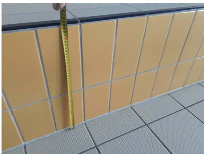
foto /56/ Šířka podstupnice schodů (hladká dlažba)
